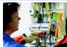
Test izolace na deskovém rozvaděči
